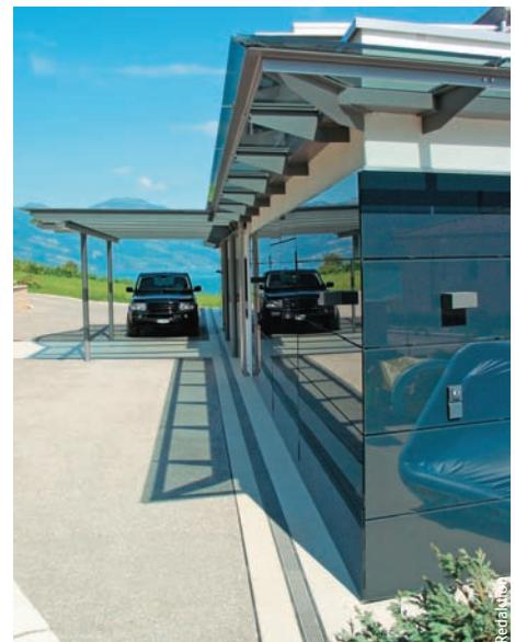
**Die mit Siebdruck versehene Glasfassade und integrierter Doppelflügeltür. Die Fassade wird um die Gebäudecke geführt.**
