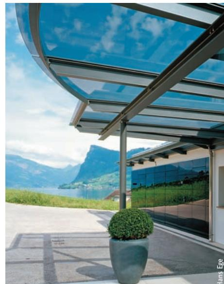
**Überdachung beim Hauseingang mit gläsernem, automatisiertem Falt-Schiebe-Tor.**
