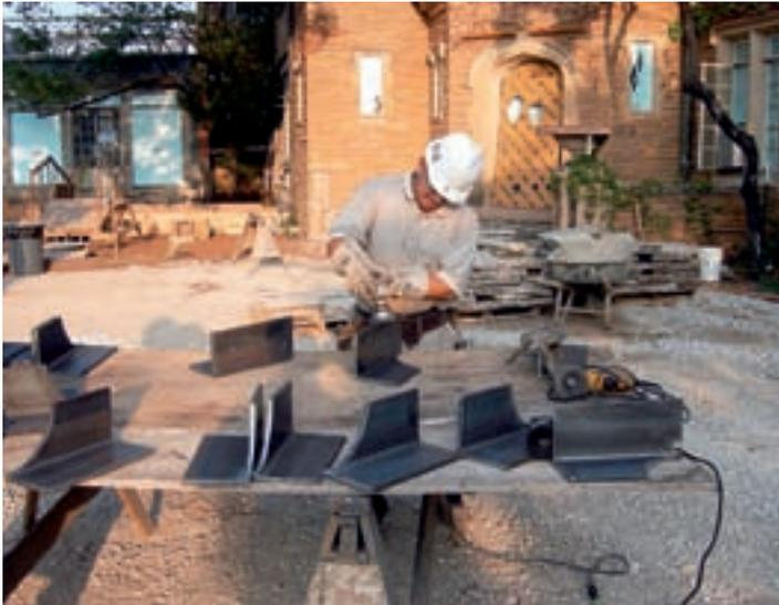
**Links: Andere Leute, andere Sitten: Der örtliche Stahlbauer bearbeitet seine Stahlteile direkt auf der Baustelle.**
