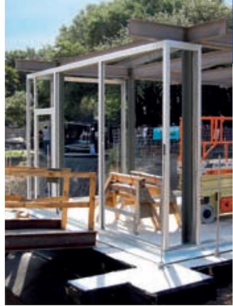
In der Umgebung des ca. 5000 m<sup>2</sup> grossen Grundstückes wurde eine grosse Poollandschaft mit freistehendem Outdoor-Livingroom in der Grösse von 16x6,5 m geplant. Diese Stahlbaukonstruktion sollte Raum für eine kleine Küche sowie einen überdimensionalen Esstisch bilden.
